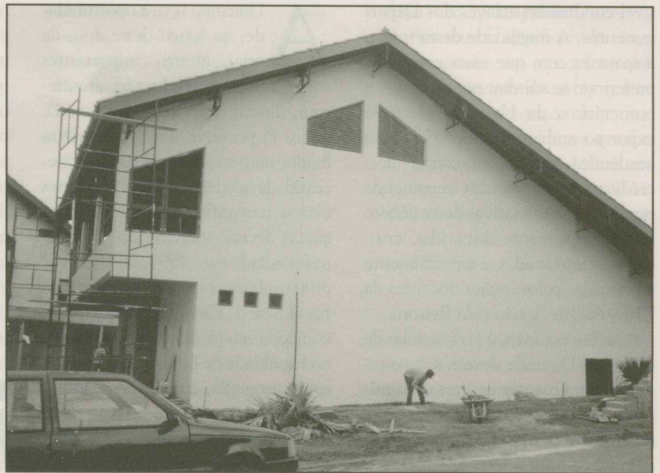
Nova sede em etapa final de construção: anfiteatro para 170 pessoas...
